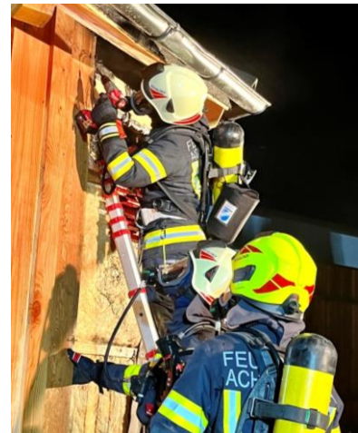
Atemschutztrupp beim Öffnen einer Holzverkleidung
